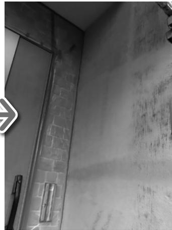
補修した後が目立たないように、モルタルで滑らかに仕上げます。
