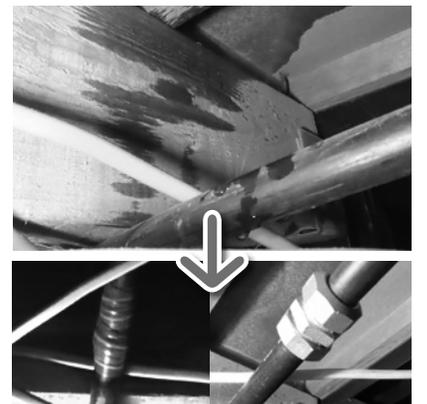
応急処置で水止めテープをまき後日、給水管を入れ替えて解決
